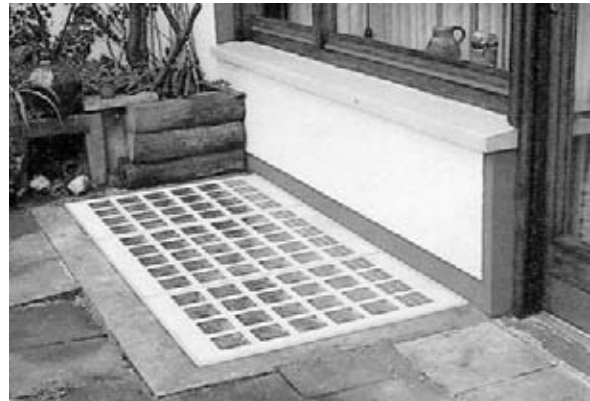
Bild 3.44: Abdeckung mit Glasbausteinen
