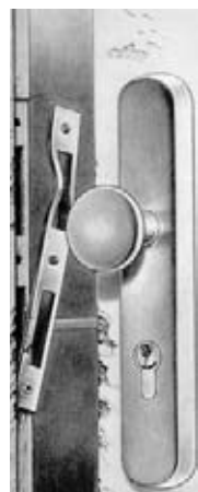
Bild 3.21: Ausgerissenes Schließblech
