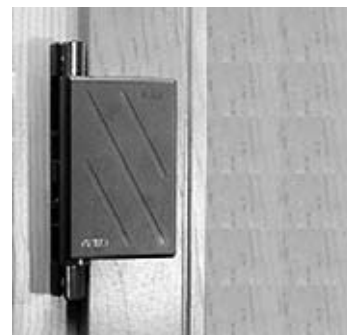
Bild 3.24: Bandseitensicherung
